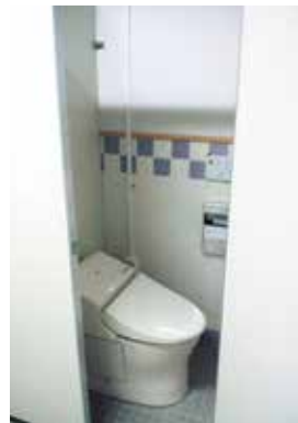
改良した会館1階女子トイレ
