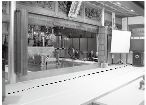
中外陣の点線部分に間仕切りを設置
