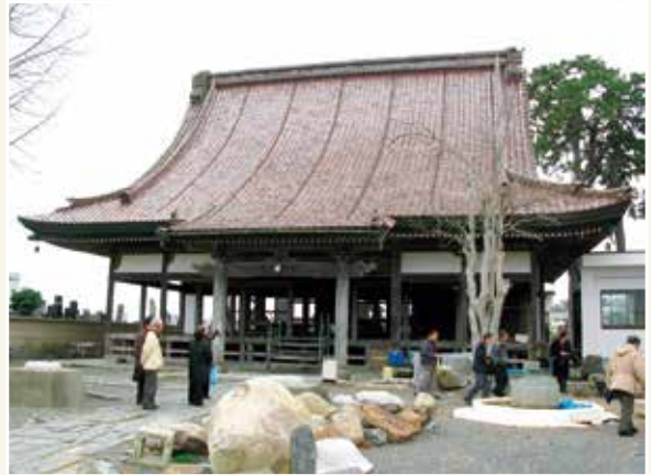
石巻市「称法寺」本堂の被災状況 (24.11.26)
