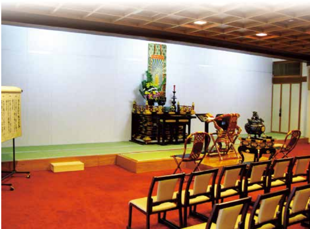
内陣床漆塗補修などの工事のため間仕切りされた本堂 (25.4.9)
