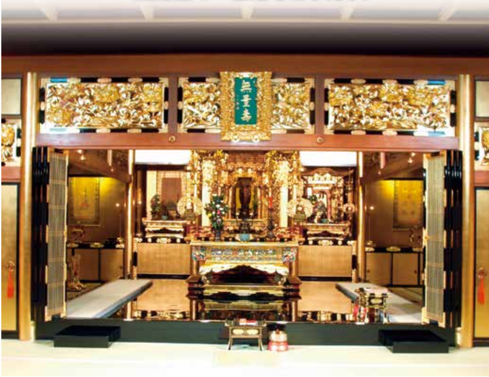
内陣床と框の黒漆塗・金箔補修等の工事完了により 厳かに光輝き報恩講を待つ本堂内陣 (25.9.15撮影)
