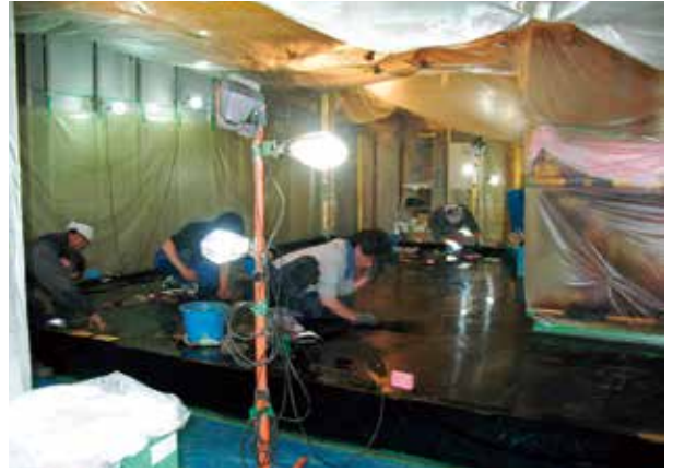
本堂内陣床蠟色漆塗り仕上げ工事の様子（25.6.11）
