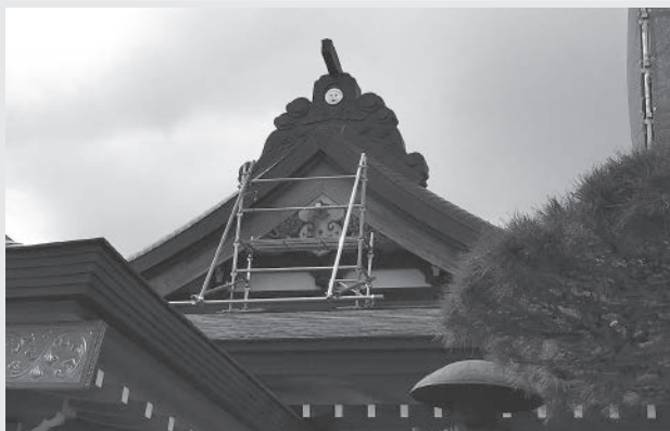
(本堂屋根入母屋にも足場 29.4.9)
