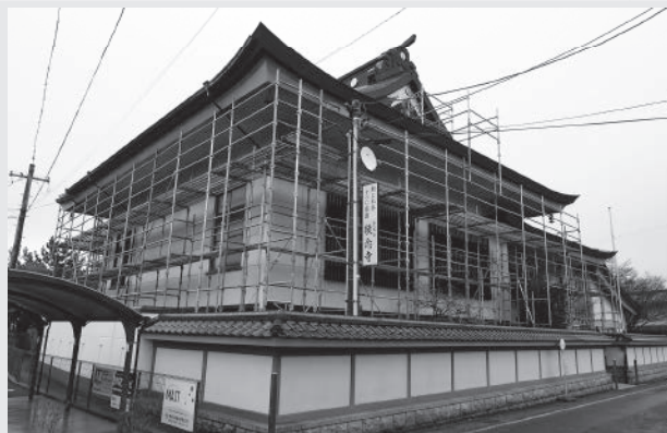
(寺院を取り囲んだ足場 29.4.9)
