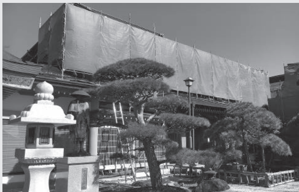
(外壁塗装のためシートで保護 29.4.23)
