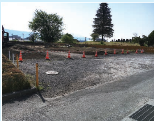
(22台駐車可能となります: 1.5.12現在工事状況)
