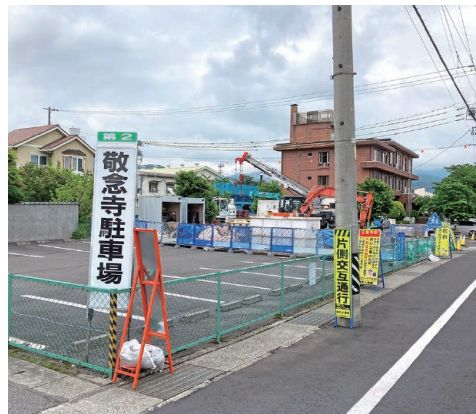
塚間川改修工事中
