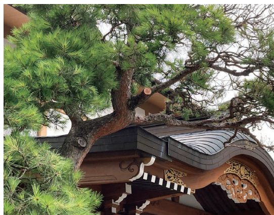
枯れた枝を伐採(3.8.1)
