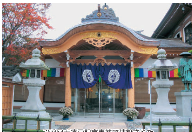
750回大遠忌記念事業で建設された参拝ホール（平成20年7月竣工）
