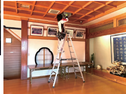
(会館ホール天井の工事のようす)
